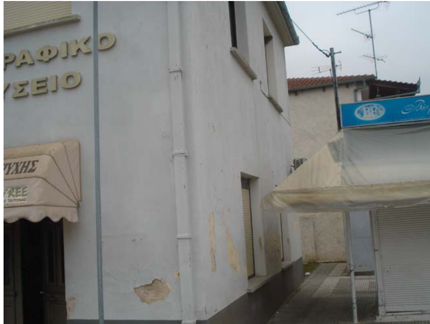
Φώτο 1: Αποξήλωση εξωτερικών επιχρισμάτων
