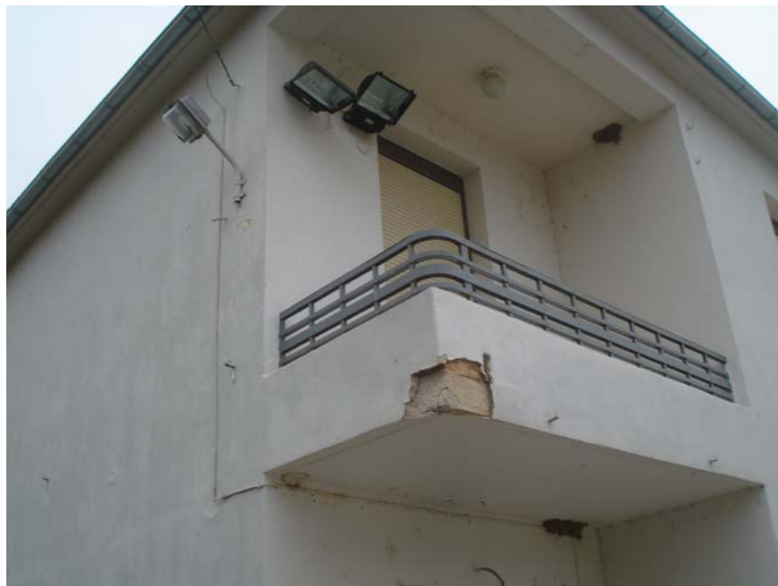
Φώτο 2: Αποξήλωση εξωτερικών επιχρισμάτων
