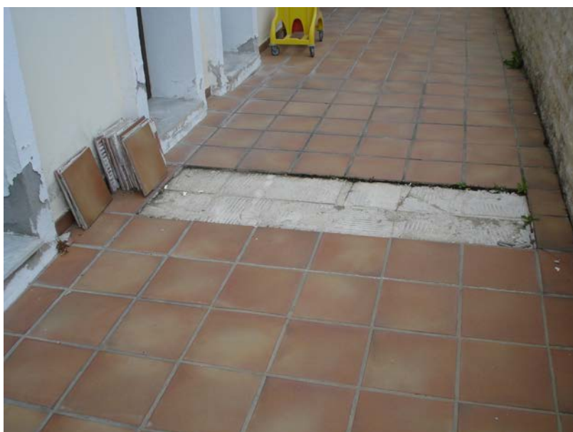
Φώτο 4: Αποξήλωση πλακιδίων από το δάπεδο εξωτερικού χώρου
