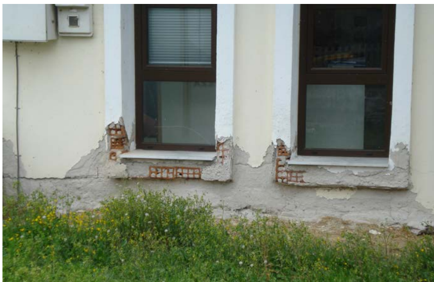
Φώτο 2: Αποξήλωση εξωτερικών επιχρισμάτων στο κτίριο του Δημαρχείου
