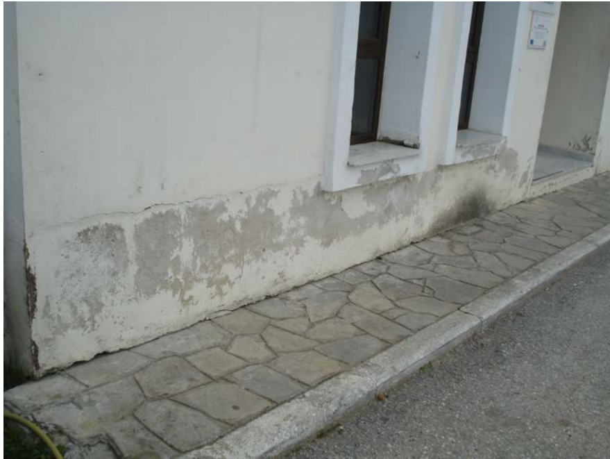
Φώτο 1: Αποξήλωση εξωτερικών επιχρισμάτων στο κτίριο του Δημαρχείου
