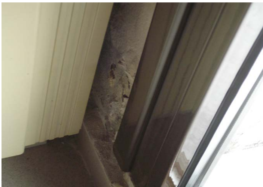
Φώτο 3: Εμφάνιση υγρασίας στο εσωτερικό του κτιρίου
