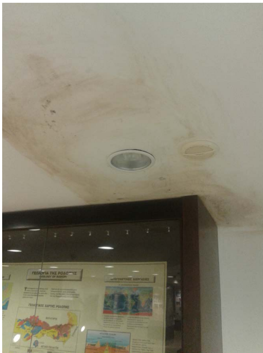
Φώτο 7: Εμφάνιση υγρασίας στην οροφή της αίθουσας εκθεμάτων του Μουσείου Φυσικής Ιστορίας
