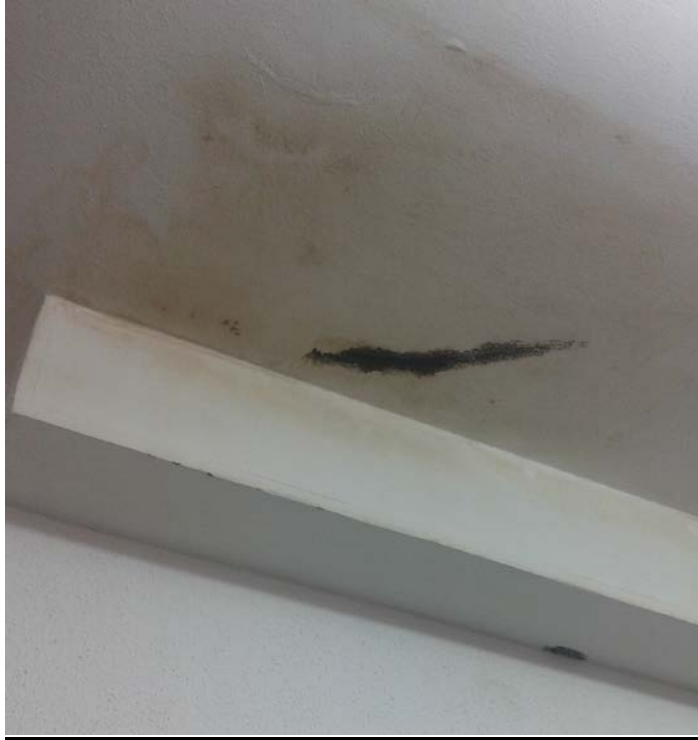
Φώτο 8: Εμφάνιση υγρασίας στην οροφή του γραφείου επιστάτη του Μουσείου Φυσικής Ιστορίας
