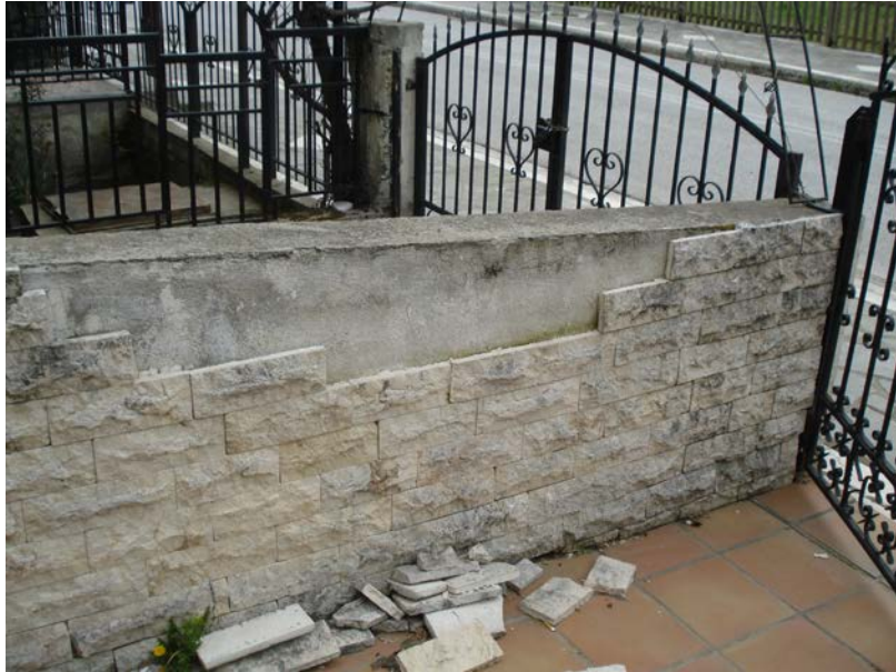
Φώτο 5: Αποξήλωση πλακιδίων από την επένδυση του τοίχου περιφραξης
